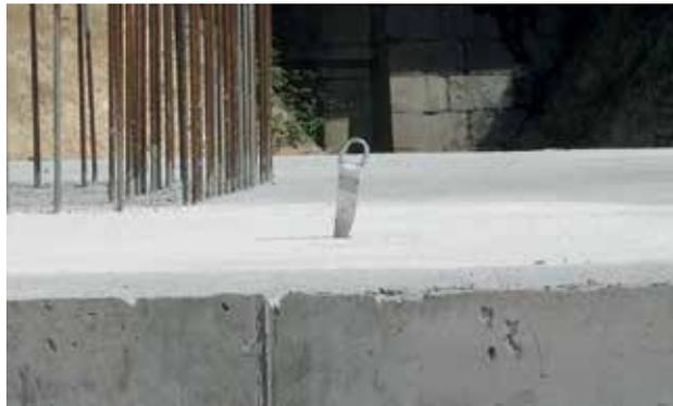
Dispositivo de anclaje destinado a instalarse embebidos en el interior de la estructura de hormigón armado, se instala con anterioridad a su vertido.
