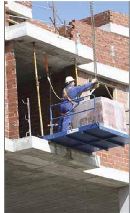
Dispositivo de anclaje para ser instalado con TACO MECÁNICO en estructuras de hormigón armado.
