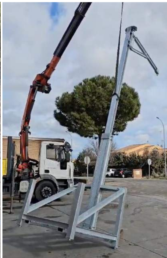
Elevar la estructura de forma progresiva y controlada
