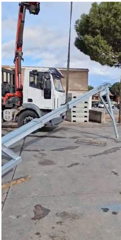
Elevar la estructura de forma progresiva y controlada
